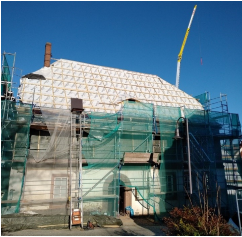
Baustelle - Pfarrhaus Frohburg
